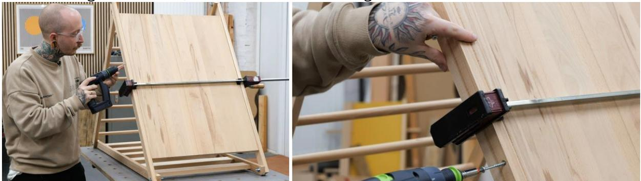
Schritt 11: Buchenplatte auf das richtige Maß schneiden, mit einer Zwinde in der Rahmenkonstruktion festmachen und sicher verschrauben.
