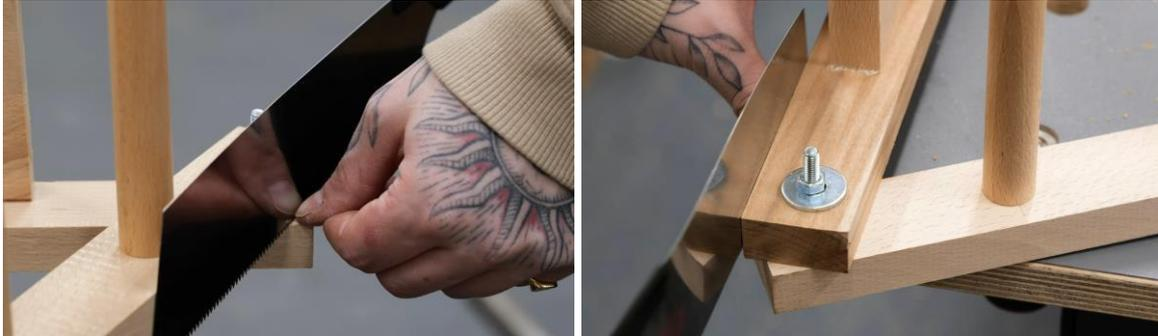
Schritt 12: Kanten absägen, überstehenden Gewindestangen kürzen und final die Oberseite zum Schutz der Kinder abschleifen.
