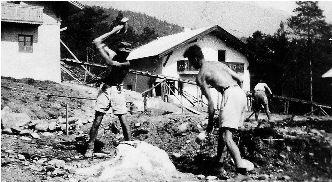
Bauarbeiten im ersten SOS-Kinderdorf in Imst 1950
